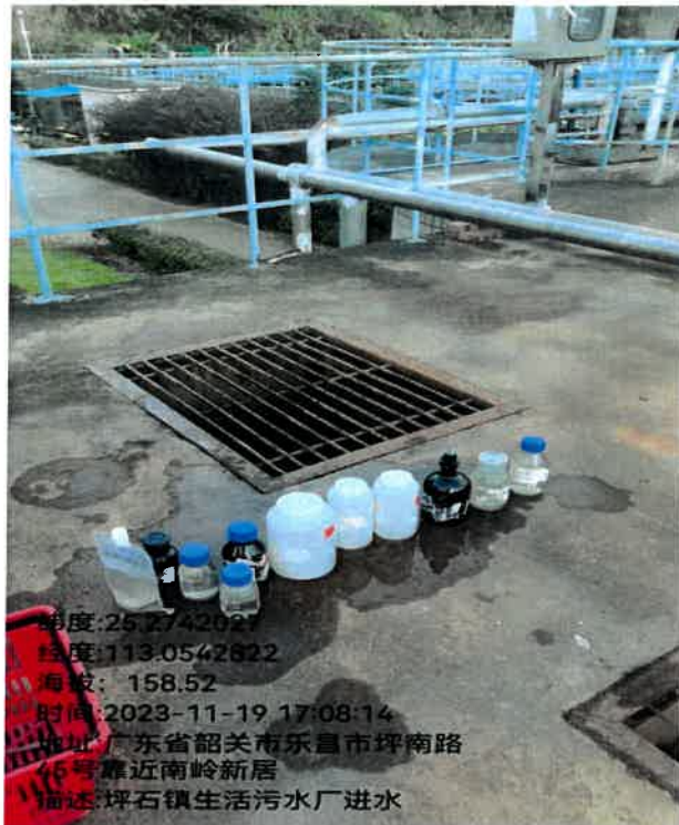
污水厂进水口
